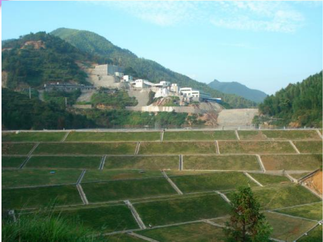
规划合理的福建武夷山上西坑铅锌矿的尾矿库
