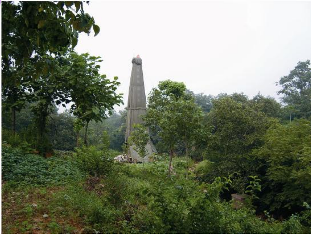
河南百炉沟铅锌矿在林密的山脊进行钻探施工
